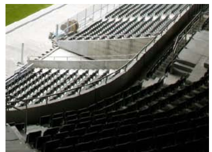
Stade de Suisse Wankdorf Bern Architektenteam Luscher, Schwaar & Rebmann Groupe d'architectes Luscher, Schwaar & Rebmann
